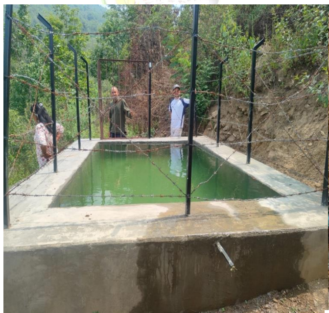
म.न.पा १० कागती खेति विस्तारको लागि सिचाई पोखरी निर्माण
